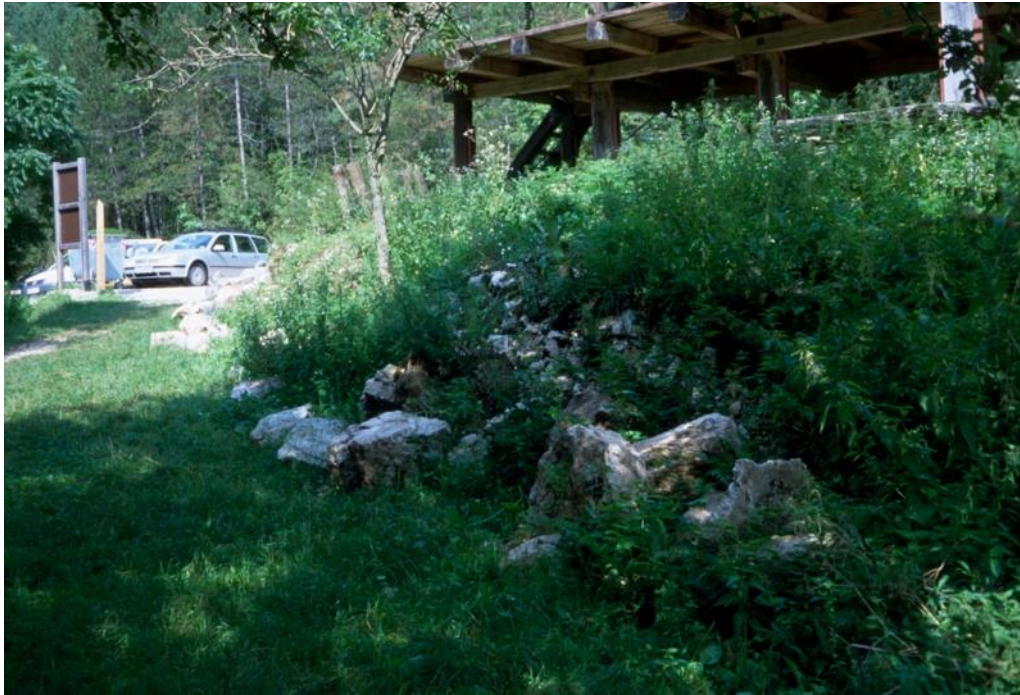
Poškodovana kamnita ograja v bližini Golobarske žičnice (Makroseizmični arhiv ARSO)
