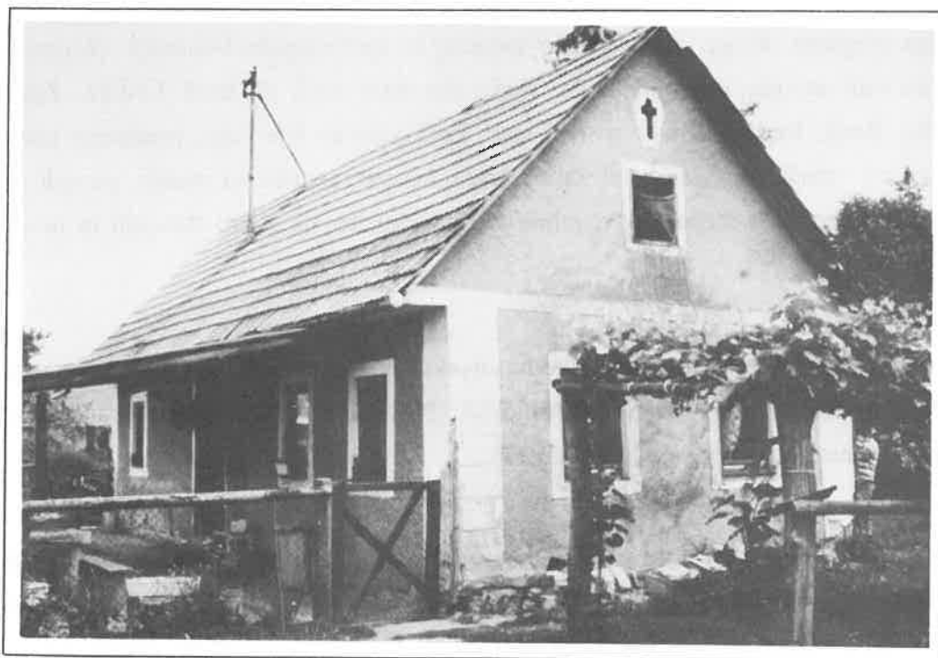
Slika 11: Pogled na stanovanjsko hišo v Borštu, ki je bila ob potresu najbolj poškodovana.
