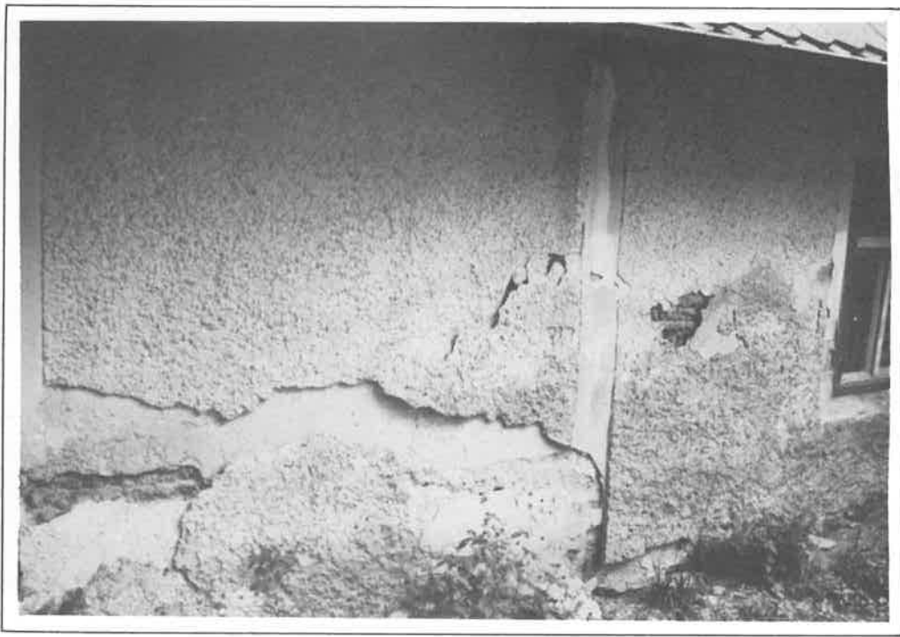
Slika 23: Odpadanje velikih kosov ometa na stanovanjski hiši v Loperšicah.
