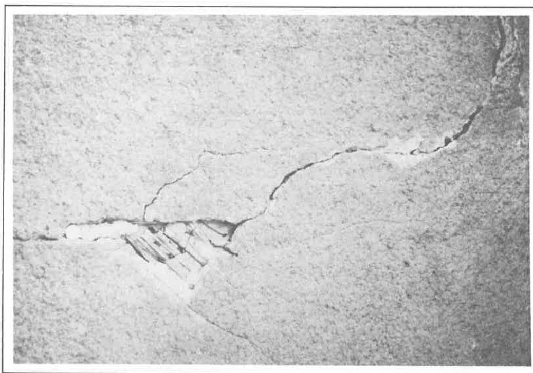
Slika 13: Odpadanje koščkov ometa na stiku polnila z lesenim ogrodjem.
