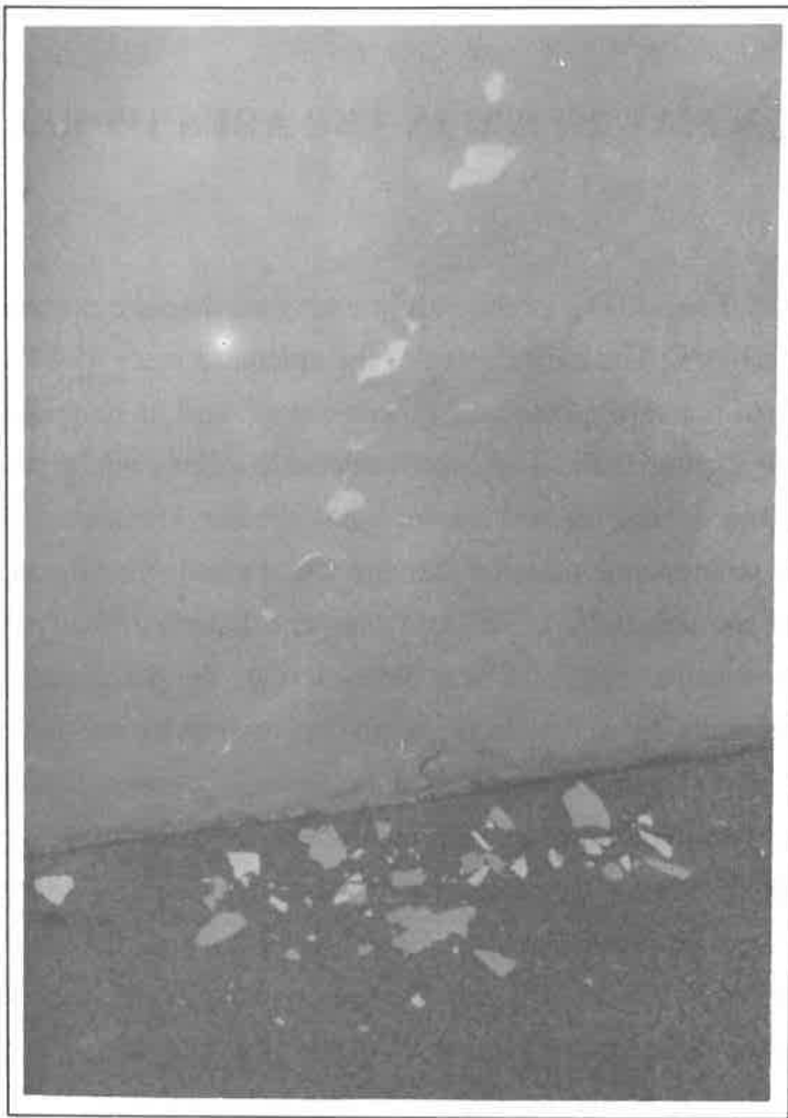
Slika 16: Odpadli koščki ometa v cerkvi v Gribljah.
