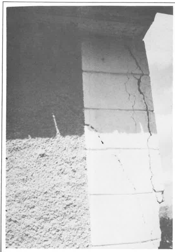
Slika 12: Globoke razpoke v vogalu hiše.
