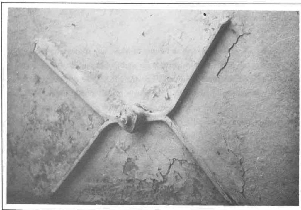
Slika 17: Sidranje vezi na zidu v cerkvi v Gribljah.
