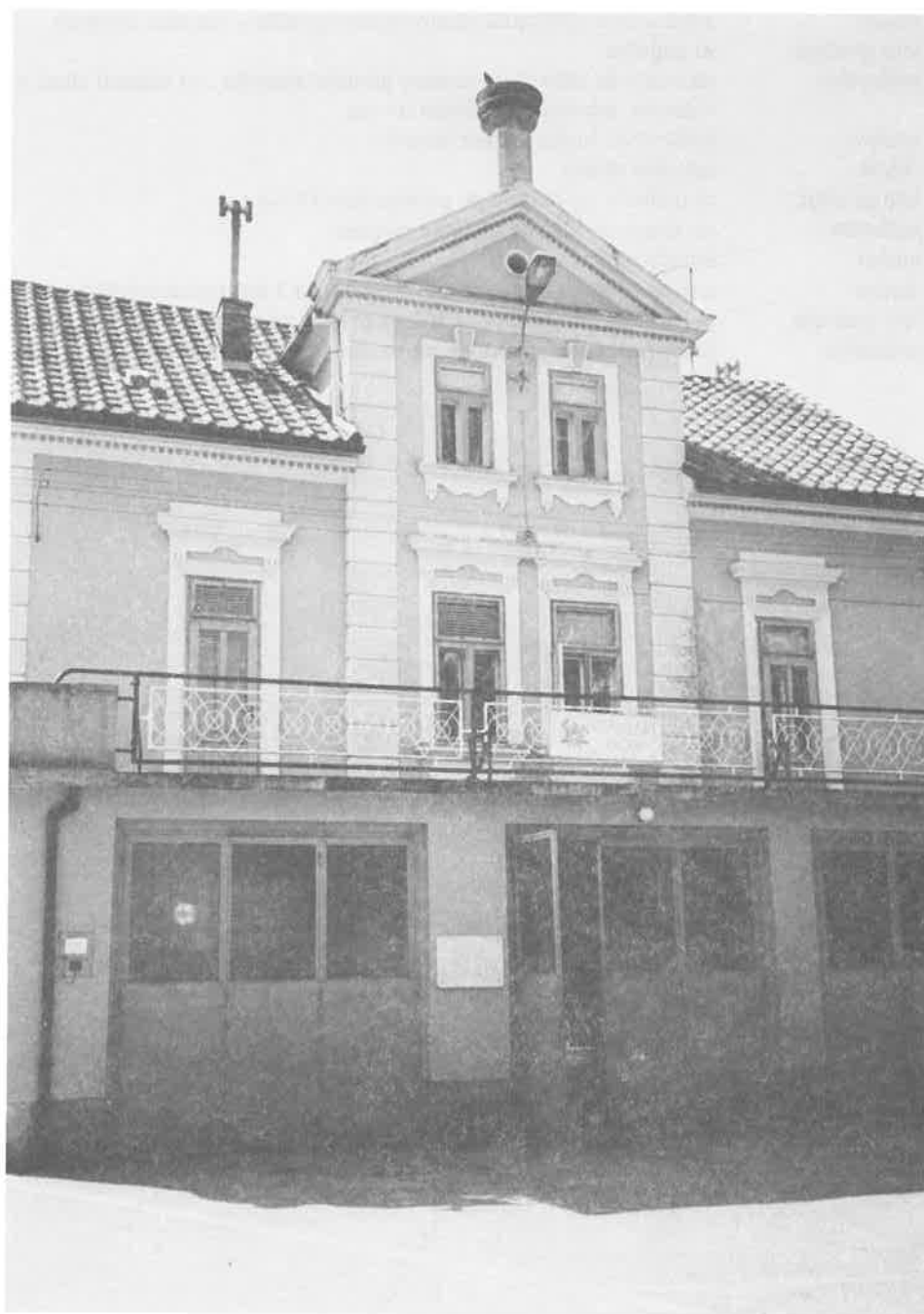
Slika 19: Pogled na gasilski dom v Ilirski Bistrici, Titov trg 11.
