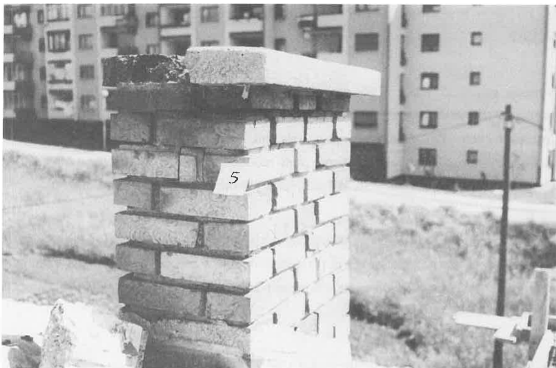
Slika 37: Odlom dela dimnika na stanovanjski hiši v Ilirski Bistrici, Gubčeva 26 a.
