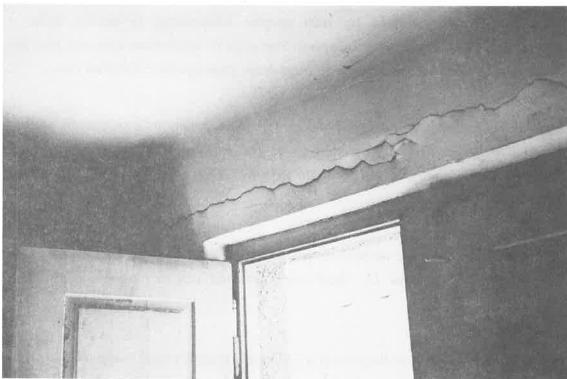
Slika 23. Razpoke v ometu gasilskega doma v Ilirski Bistrici, Titov trg 11.
