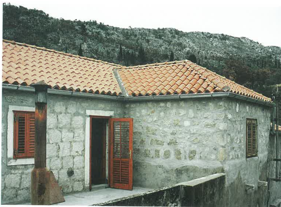
Slika 2. Med vojno požgana in kasneje dobro obnovljena stanovanjska hiša v vasi Mravinca ni utrpela poškodb. Vzidane so bile horizontalne vezi, požgane lesene stropove so nadomestili z armirano betonskimi.
