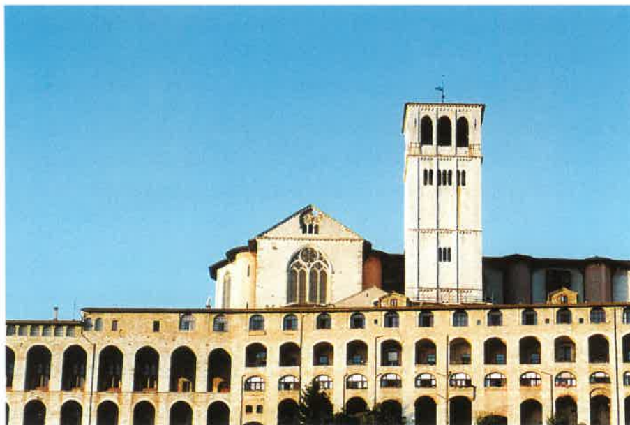
Slika 7. Poškodba na baziliki sv. Frančiška v mestu Assisi. Pri padcu dela ostrešja so umrli štirije ljudje (foto: I. Cecić).
