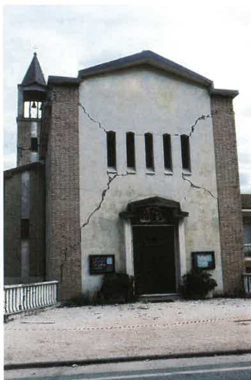
Slika 8. Značilne diagonalne razpoke na cerkvi in zvoniku v kraju Nocera Scalo (foto: J. Lapajne).
