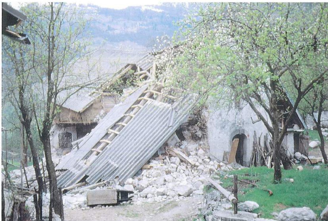
Slika 12. Popolnoma uničen objekt na planini Polog nad Tolminom (poškodba 5. stopnje)
