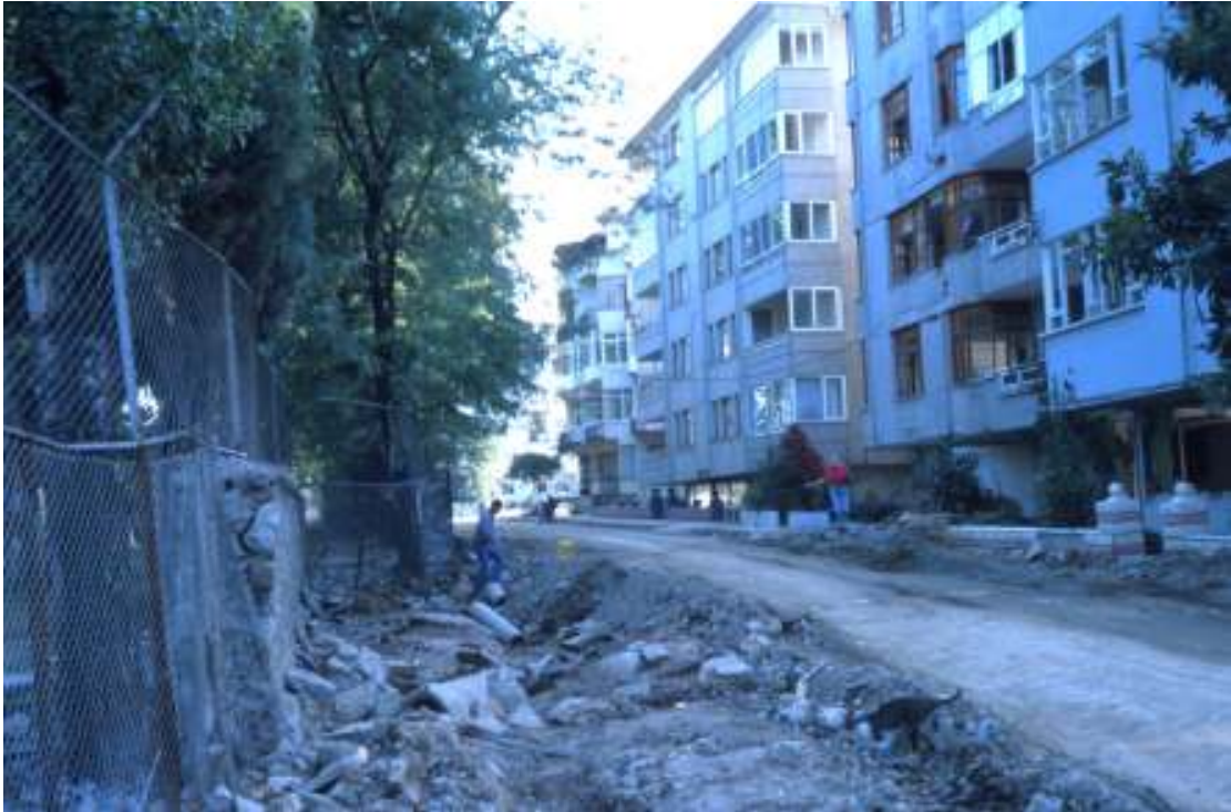
Slika 18. Kamnita ograja se je ob horizontalnem premiku zamaknila za več kot 2 metra (foto: R. Vidrih).
