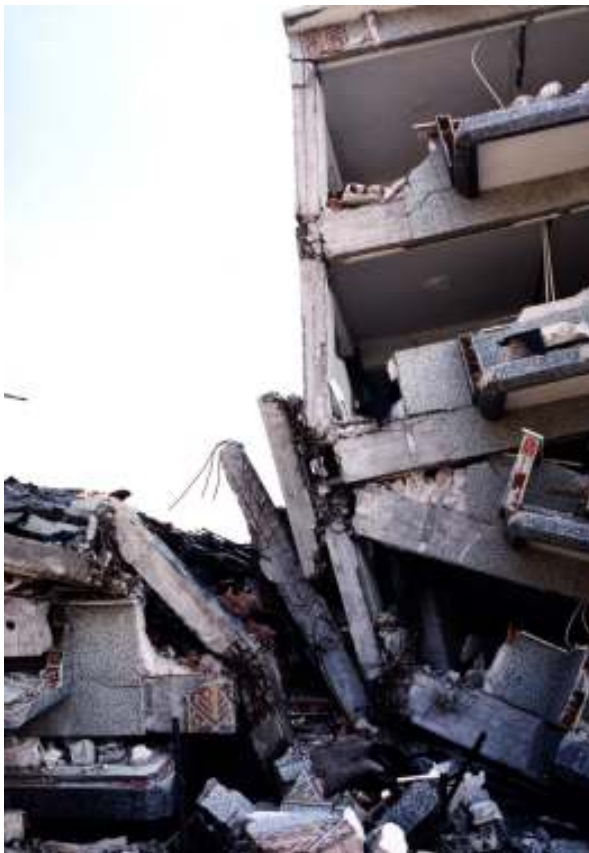
Slika 5. Del štirinadstropnega bloka v Adapazarju se je sesedel kot palačinke (foto: M. Godec). Figure 5. Part of the four-floor block in Adapazari collapsed like a stack of pancakes (photo: M. Godec).
