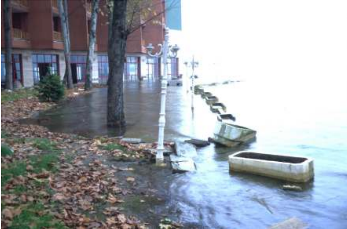
Slika 16. Del obale v Sapangi, se je skupaj s hotelom zapeljal v jezero (foto: R. Vidrih). Figure 16. Part of the coast with a hotel in Sapanga slid into the lake (photo: R. Vidrih).
