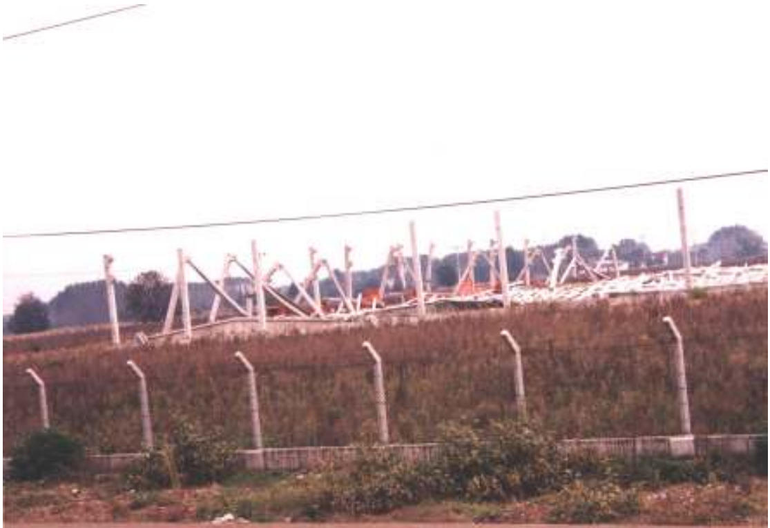
Slika 10. Tudi porušitev nove industrijske hale v Adapazarju je posledica slabih geoloških pogojev (foto: M. Godec).
