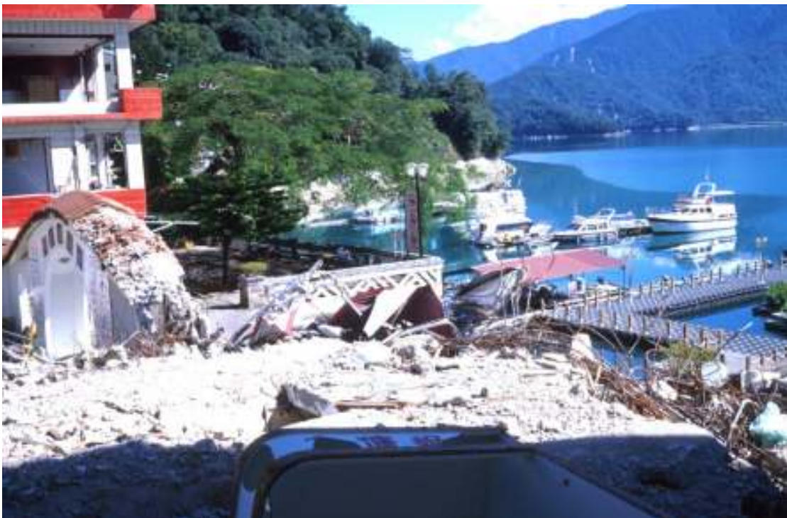
Slika 14. V neposredni bližini plazu (slika 14) je bil ob potresu močno poškodovan hotel ob jezeru Moon (foto: R. Vidrih).
