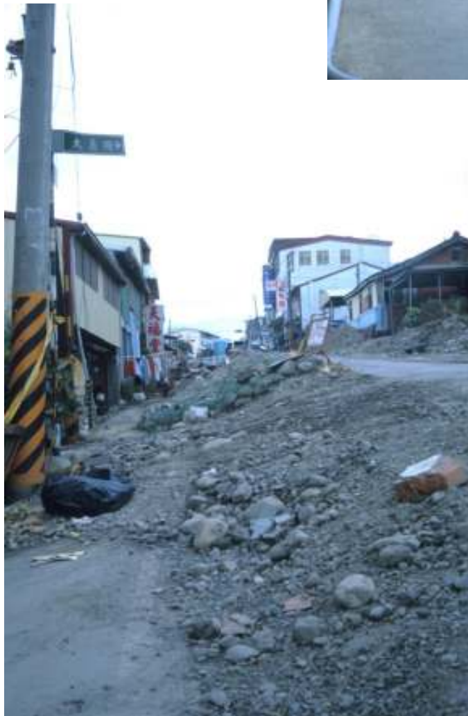
Slika 12. V posameznih naseljih je pretrg potekal po ulicah, ponekod celo pod hišami. Ena stran ulice se je dvignila nad drugo (foto: R. Vidrih).
