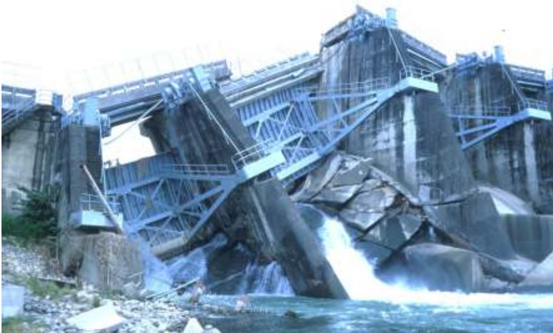
Slika 10. Na prelomu je bila postavljena pregrada Ši-Gang, ki se je zaradi površinskega pretrga porušila. Na eni strani preloma je prišlo do dviga 3 – 4 m, na drugi pa do pogreznitve 1 – 2 m (foto: R. Vidrih).
