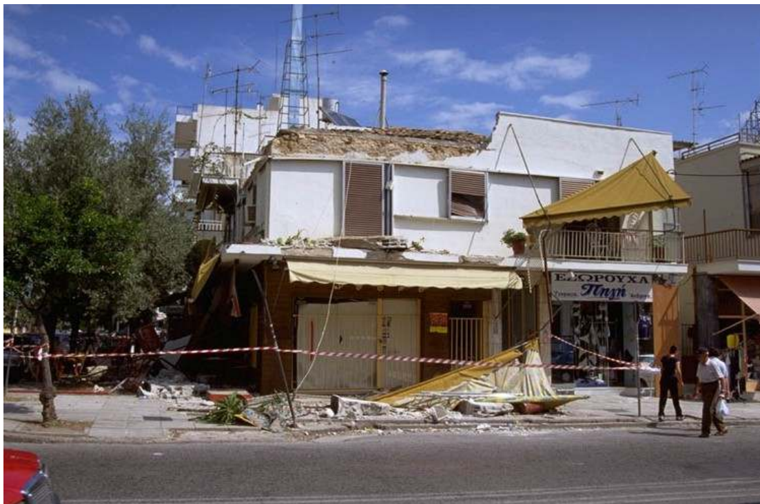
Slika 3. Težke poškodbe objektov vzdolž ulice Dekelias Odos v Atenah, ponekod so bili objekti popolnoma uničeni.
