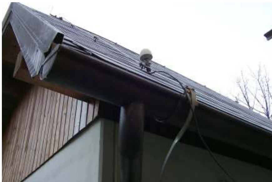
Slika 5. Postavitev antene GPS sprejemnika je zagotavljala nemoten sprejem časovnih signalov.
