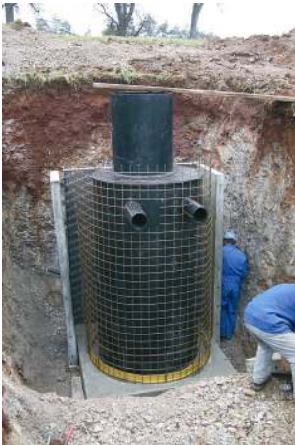
Slika 9. Sledi obbetoniranje postavljenih PHD jaškov, v katerih bodo nameščeni instrumenti. Prikazano je stanje na lokaciji Legarje 5.12.2001. (Senzor bo nameščen v 18 m globoki vrtini.) (levo)
