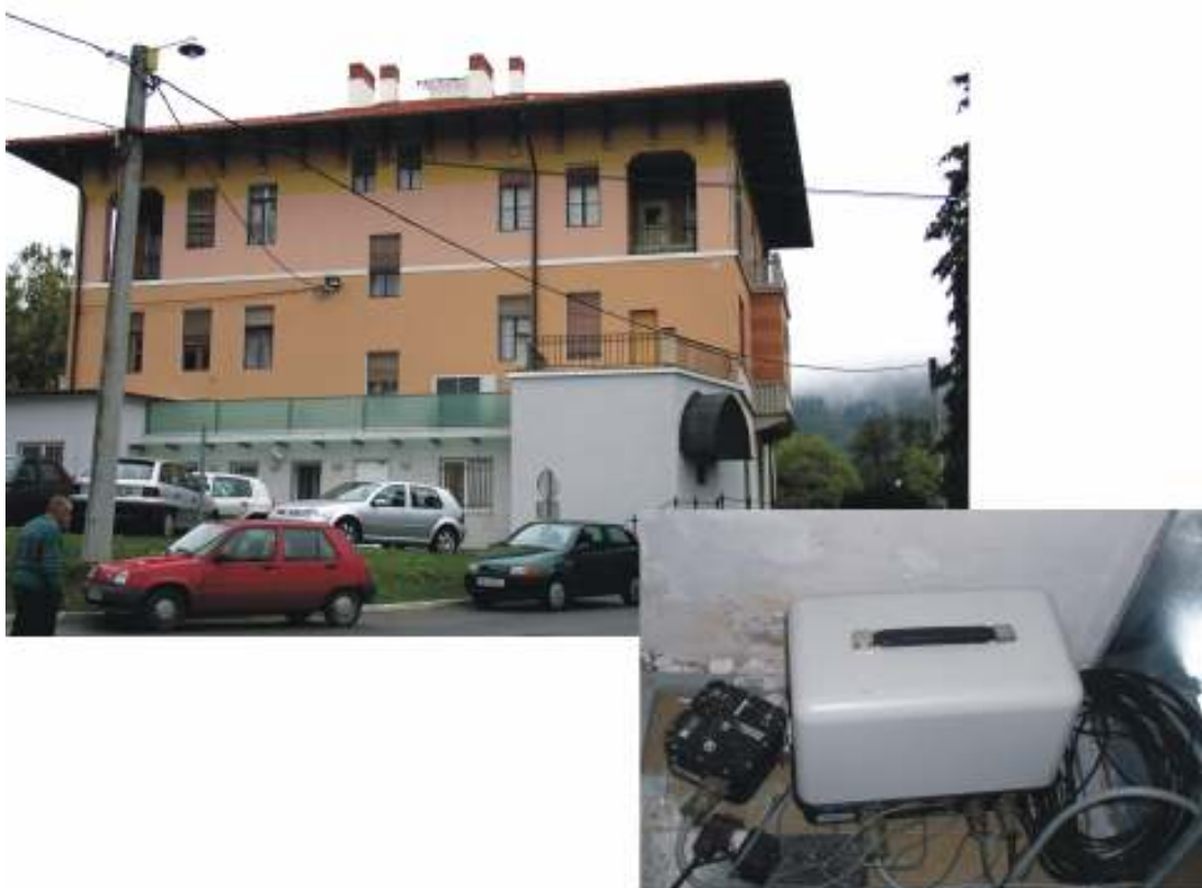
Slika 12. Akceleroğraf SSA-2 je nameščen v zgradbi občine Ilirska Bistrica. Figure 12. Accelerograph SSA-2 is installed in Ilirska Bistrica municipal building.
