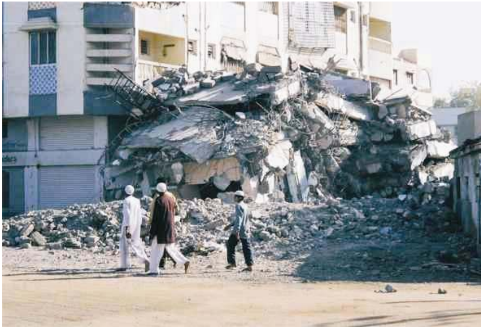
Slika 21. Obe zgradbi sta bili zgrajeni približno istočasno. Slaba gradnja zgradbe na desni je imela za posledico, da se je sesedla etaža na etažo.
