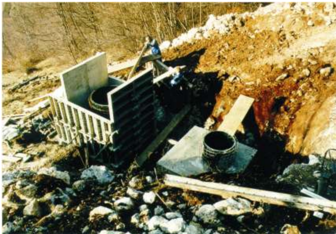
Slika 13. Stanje del na lokaciji Črešnjevce 30. januarja 2002 (opravljena betonska dela, elektroenergetski in telekomunikacijski kabel sta bila položena 4.2.2002).
