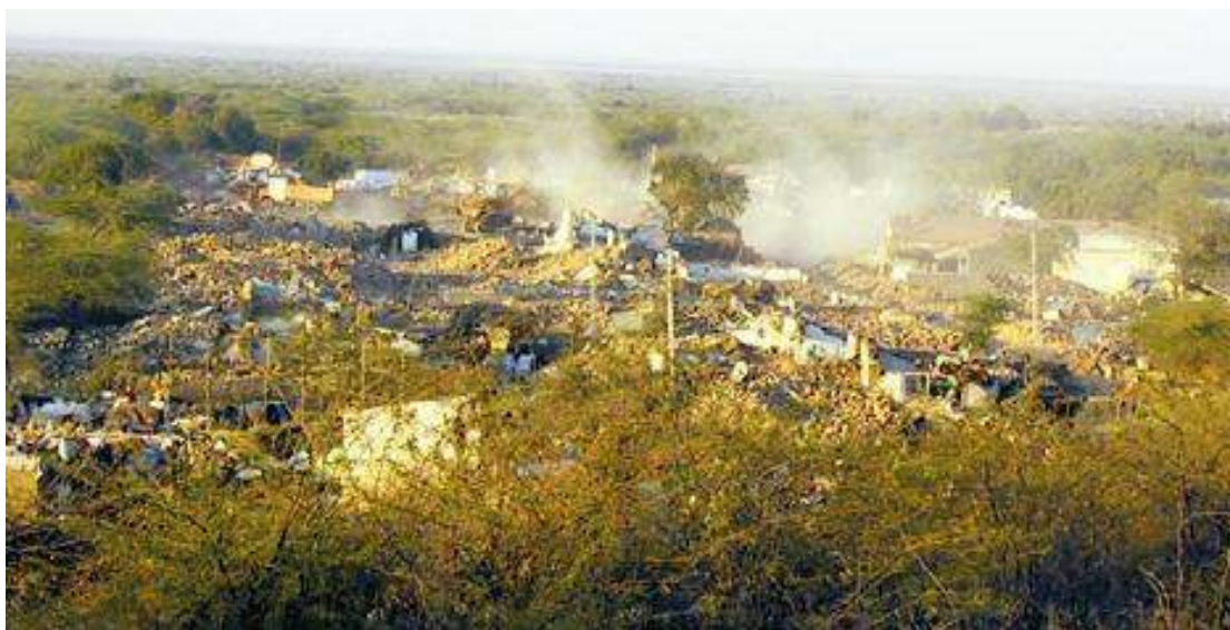
Slika 17. Jhurand. Skoraj vse zgradbe v mestu so se zrušile v povezan kup grobih kamnitih kosov. Prah, ki je viden na sliki, je posledica čiščenja. Slika je posneta približno dva tedna po potresu.
