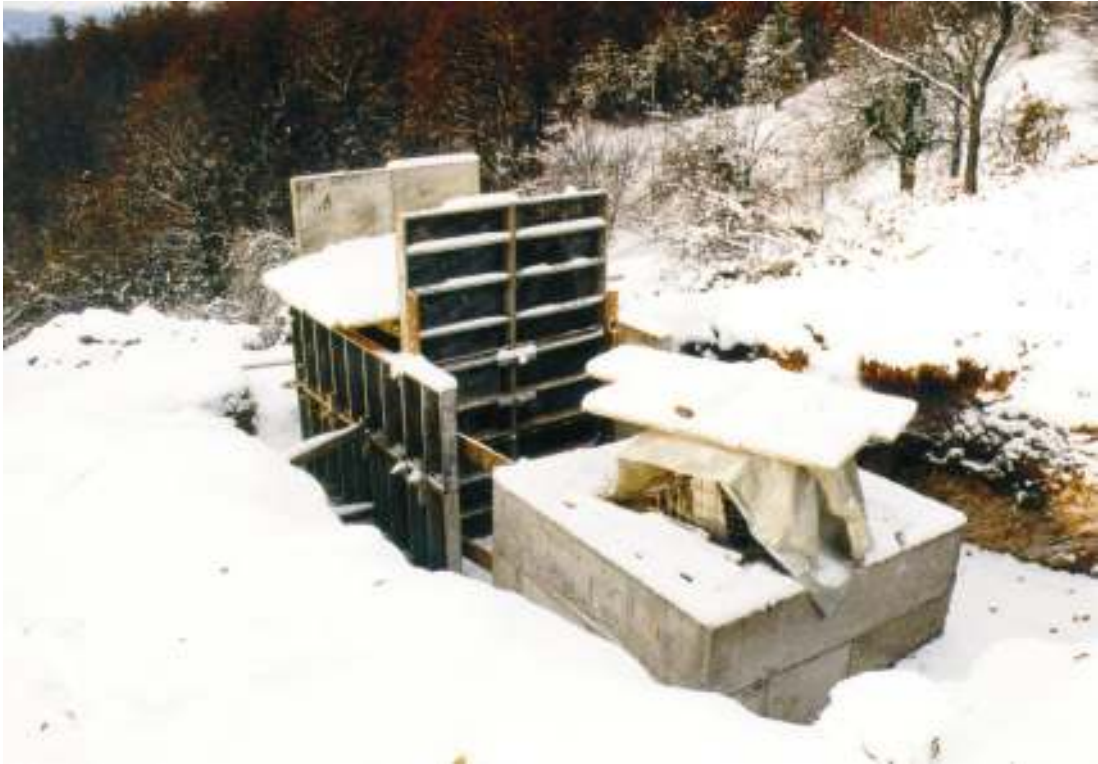
Slika 11. Stanje del na lokaciji Legarje ob prekinitvi del 14. decembra 2001 (opravljena betonska dela, onemogočeno polaganja elektroenergetskega kabla zaradi nizkih temperatur).
