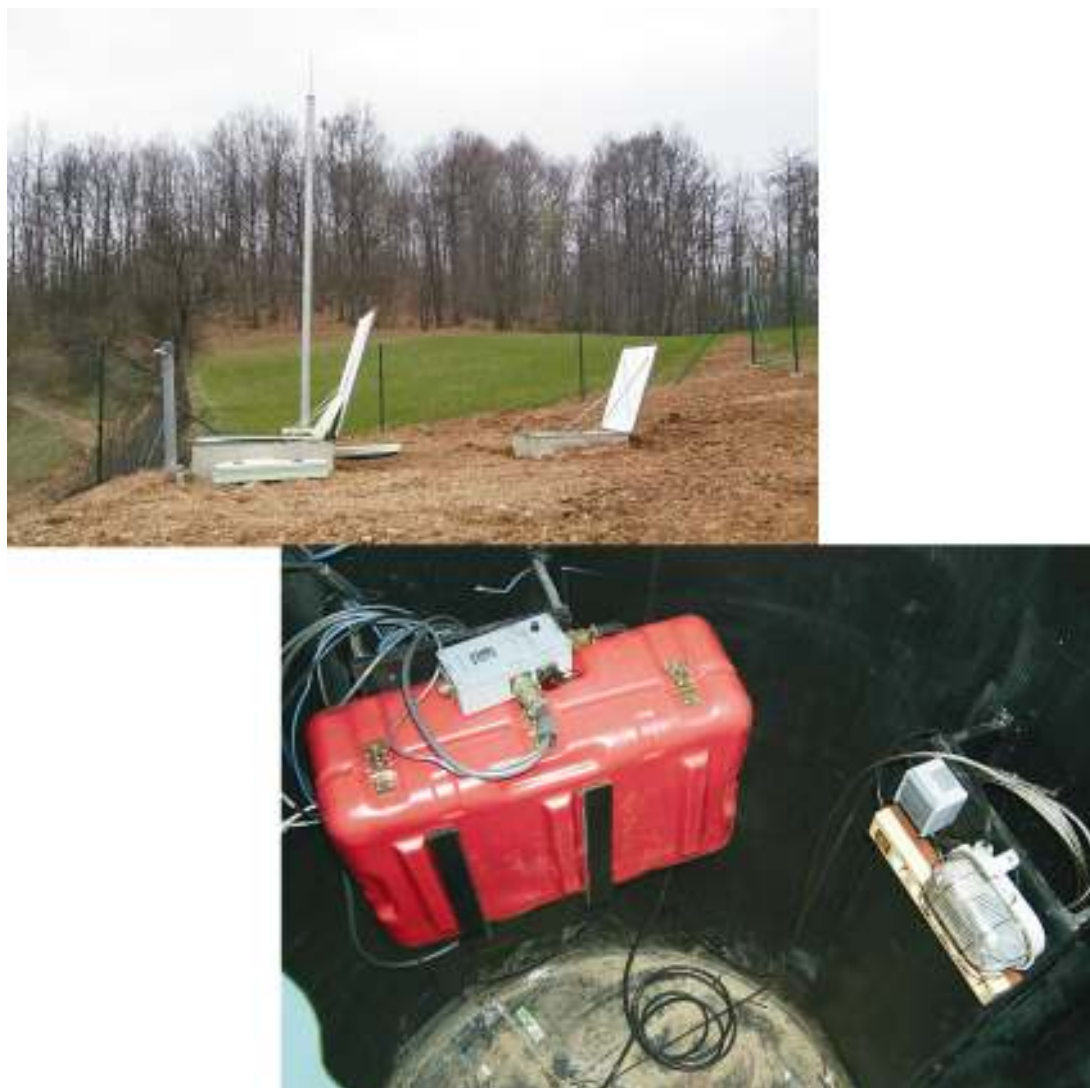
Slika 17. Dokončana potresna opazovalnica; pogled na opazovalnico Legarje (zgoraj). Q730 in prilagoditvena enota v seizmičnem jašku (spodaj). Figure 17. A completed seismic monitoring station; view of the seismic station Legarje (above). Q 730 and Breakout Box in seismic shaft (below).
