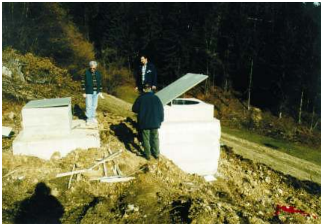
Slika 14. Stanje del na lokaciji Goliše 30. januarja 2002 (opravljena betonska dela, položena elektroenergetski in telekomunikacijski kabel).
