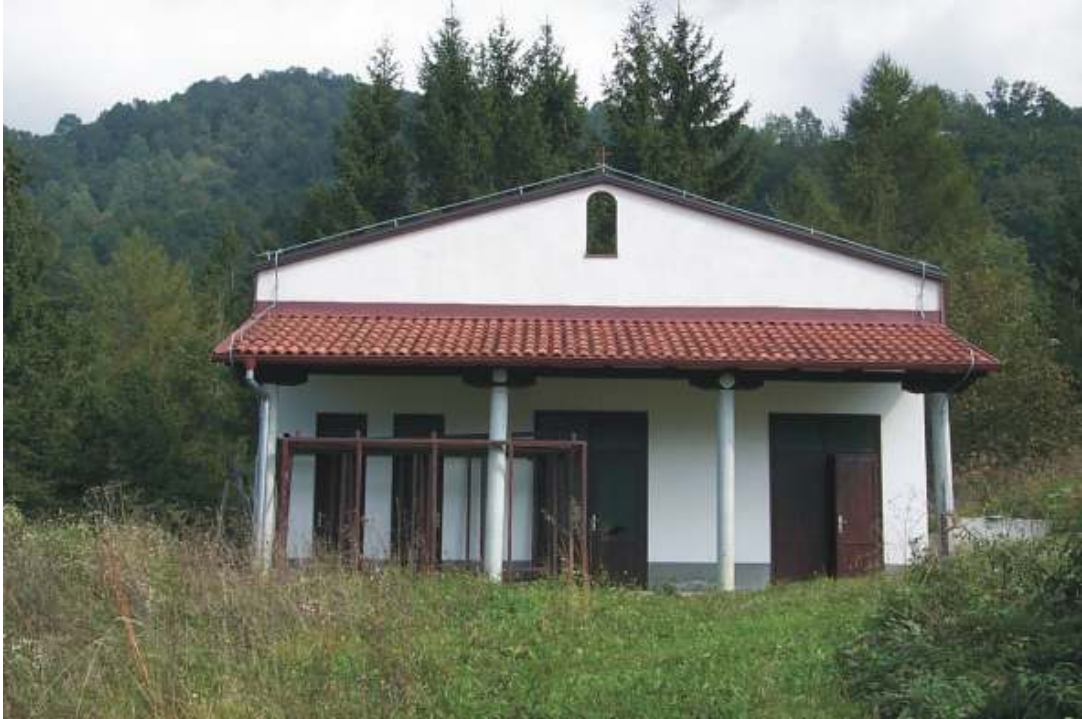
Slika 5. V Drežnici je akceleroграф Etna nameščen v mrliški vežici. Figure 2. Accelerograph Etna is installed in Drežnica mortuary.
