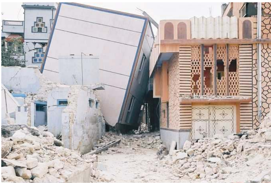
Slika 11. Novejša konstrukcija na levi se je med potresom prevrnila. Zgradba na desni pa je prestala tudi potres leta 1956.
