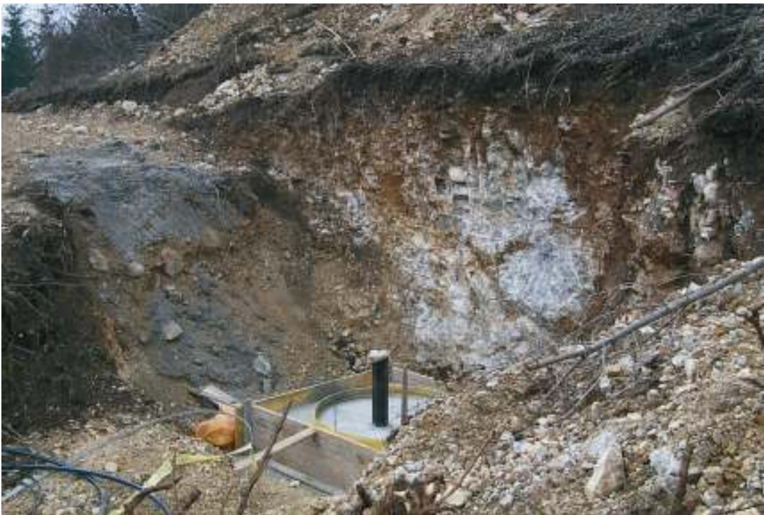
Slika 8. Naslednja faza je betoniranje podlage jaška, v katerem bodo instrumenti. Prikazano je stanje na lokaciji Goliše 5.12.2001. (Senzor je nameščen v 18 m globoki vrtini.)
