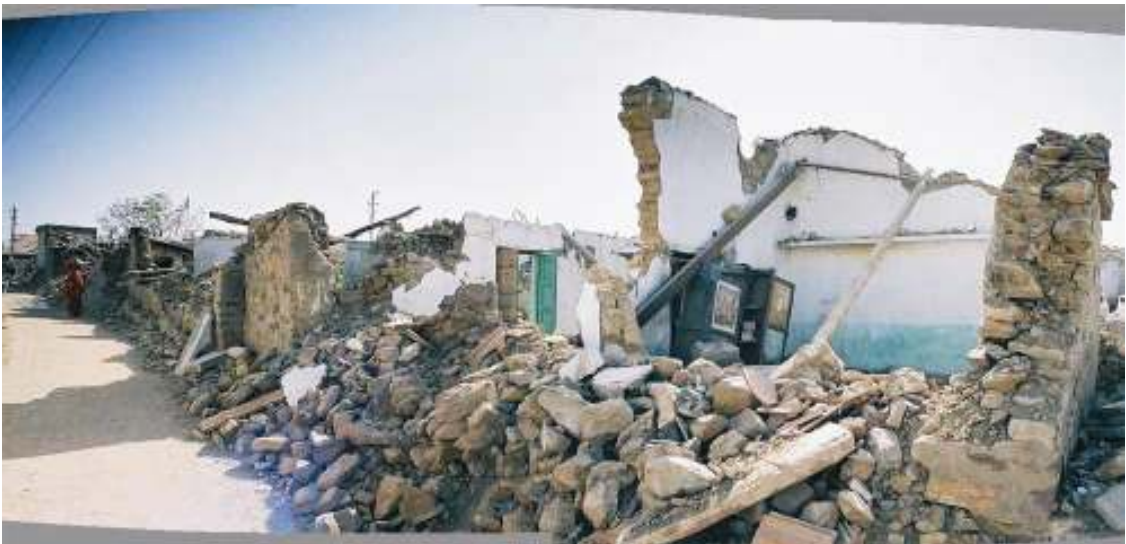
Slika 19. Pogosto so zgradbe zgrajene iz neobdelanega kamna povezanega s slabo malto. Posledica močnega potresa pri takšnih zgradbah je porušitev objekta in opustošenje mest in vasi.
