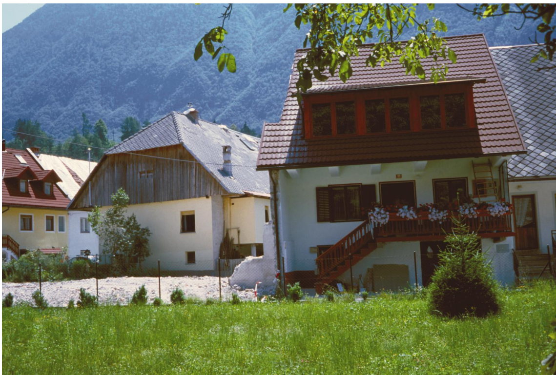
Slika 19. Zaradi lokalnih seizmogeoloških razmer so bile ponekod poškodbe nenavadne. Primer v Čezsoči kaže dve hiši, ki sta bili zgrajeni skupaj; leva je bila ob potresu uničena in so jo morali porušiti (zgoraj), desna pa je potres sorazmerno dobro prestala (spodaj).
