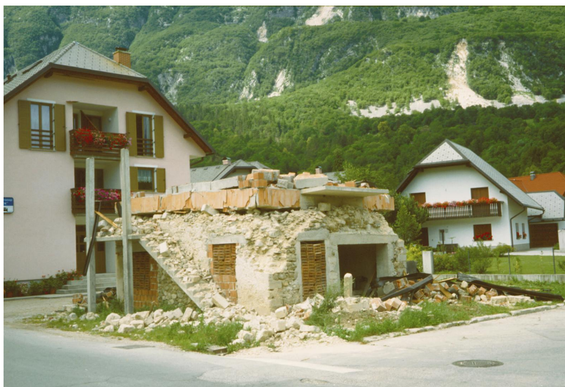
Slika 20. Uničena hiša v Mali vasi v Bovecu (zgoraj) po potresu leta 1998 ni bila sanirana. Spodnji del hiše je bil zgrajen iz neobdelanega kamna v slabi apneni malti (spodaj).
