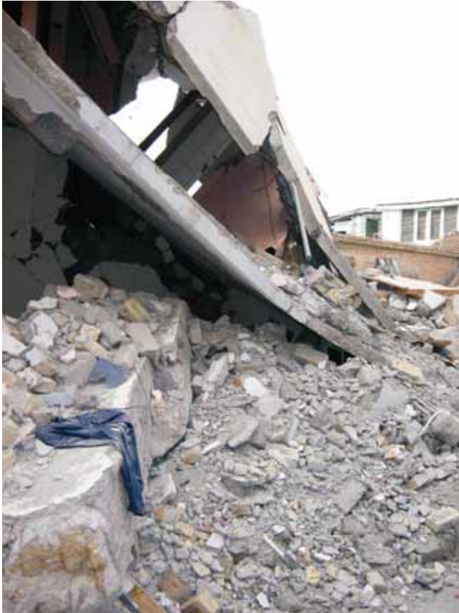
Slika 24. Muzaffarabad: ruševine zidane konstrukcije z armiranobetonskimi stropnimi ploščami.
