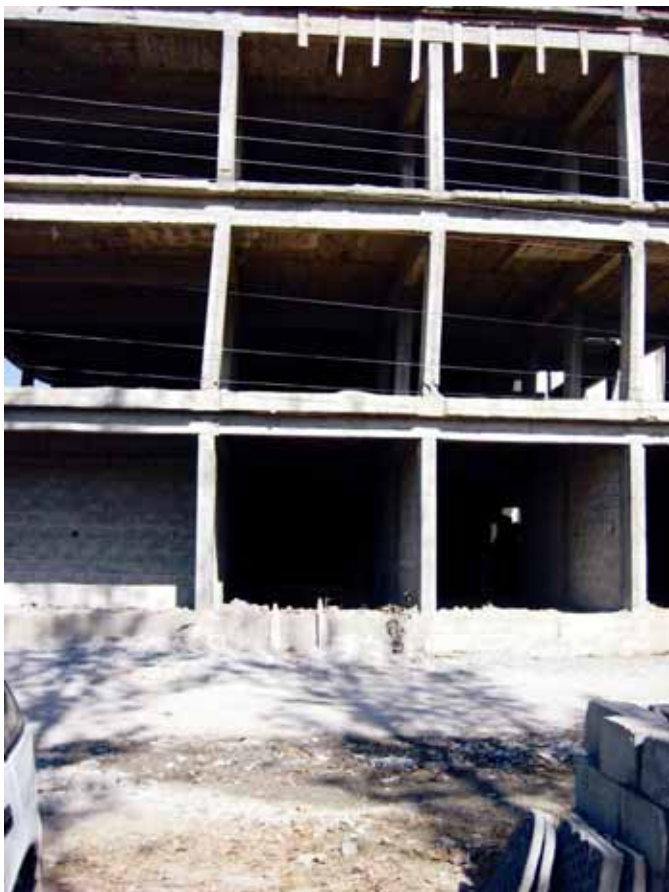
Slika 13. Prehod iz pritličja, kjer je okvirna konstrukcija zapolnjena z zidanimi polnili, v prvo nadstropjem. Detajl.
