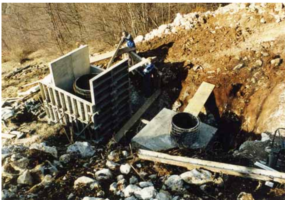
Slika 12. Betoniranje seizmičnega in pomožnega jaška.
