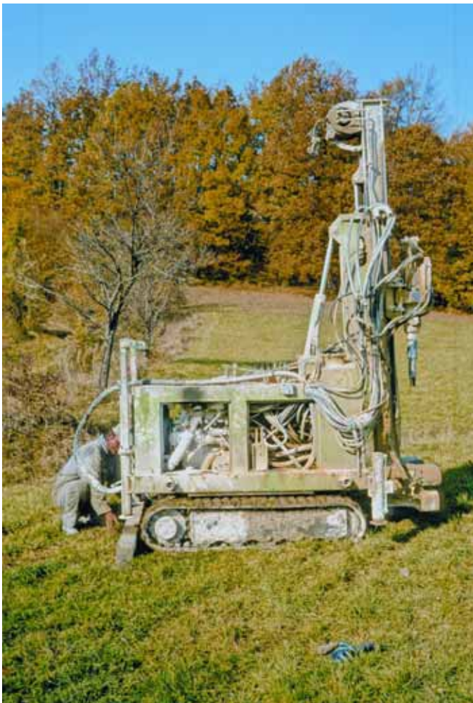
Slika 9. Zaradi slabe geološke podlage je bilo potrebno ponekod senzor namestiti v vrtino. Primer vrtanja na Legarjah.
