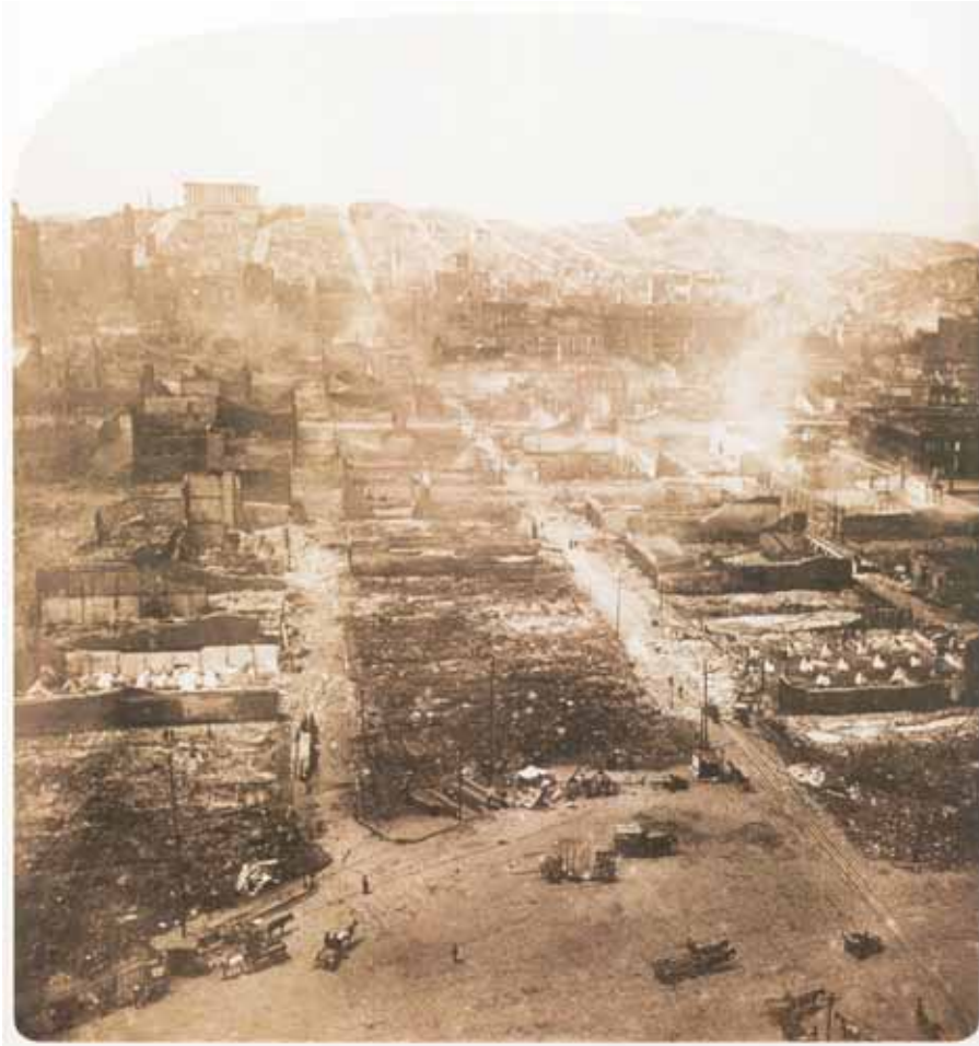
Slika 3. Leseni objekti so se »enostavno« nagnili ali celo podrli, vendar v njih ni bilo veliko žrtev. V njih so bile žrtve le v primeru požarov.
