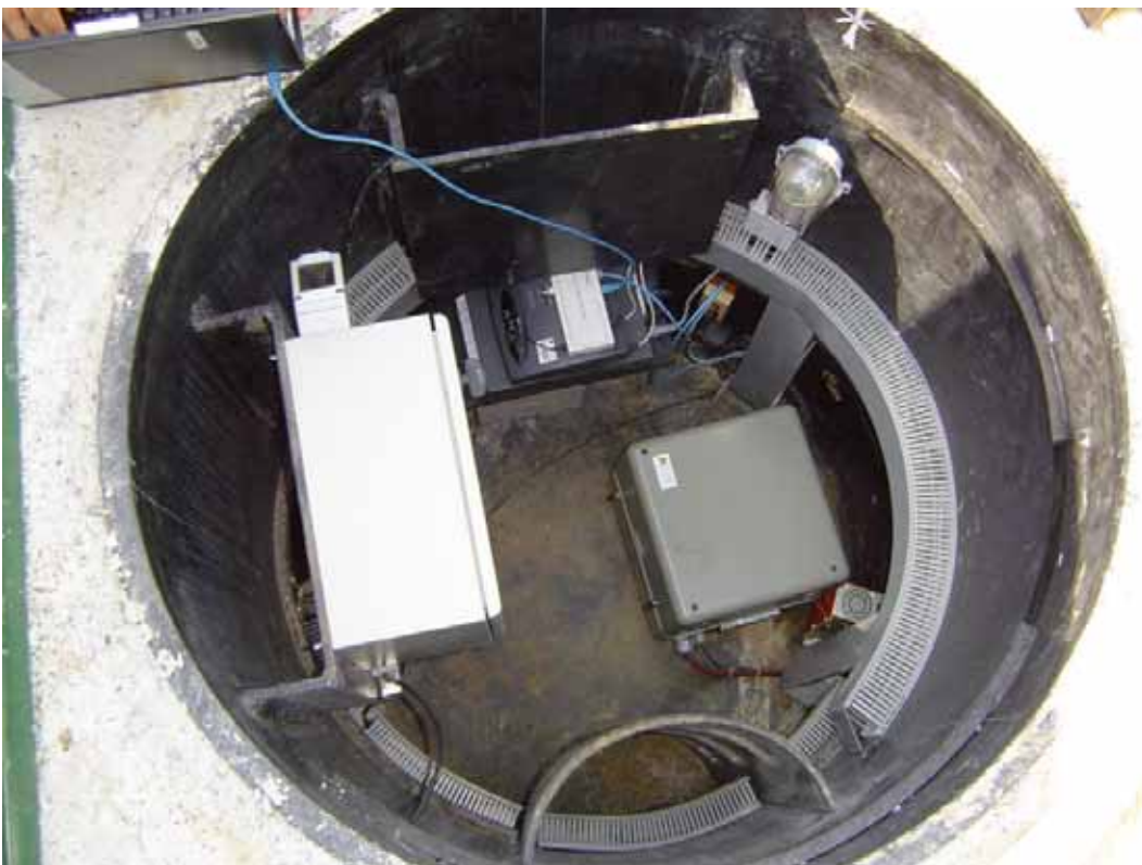
Slika 19. Pomožni jašek z brezprekinitvenim napajanjem in modemom in usmerjevalnikom za prenos podatkov.
