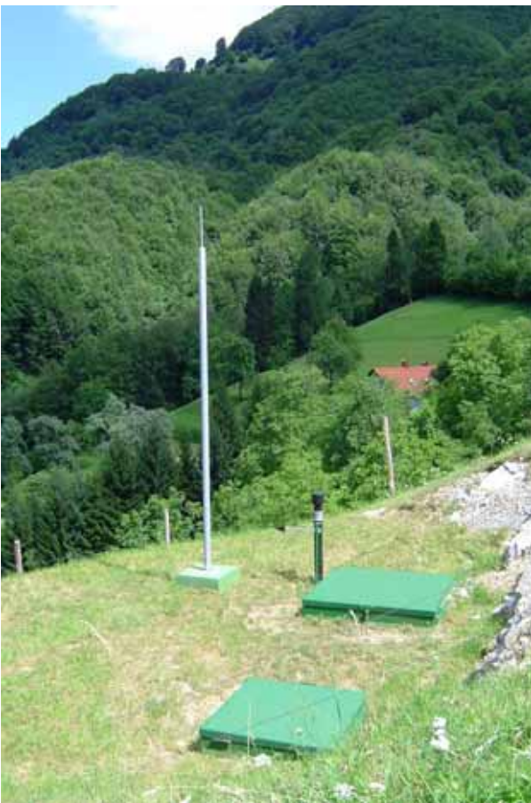
Slika 16. Končni izgled potresne opazovalnice (Čadrg nad Tolminom).
