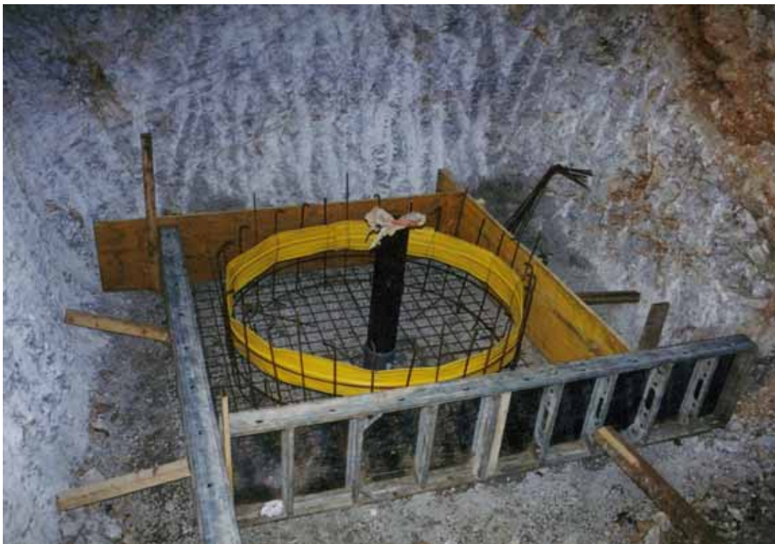
Slika 10. Naslednja faza je betoniranje podlage jaška, v katerem so postavljeni instrumenti. Prikazano je stanje na lokaciji Goliše.
