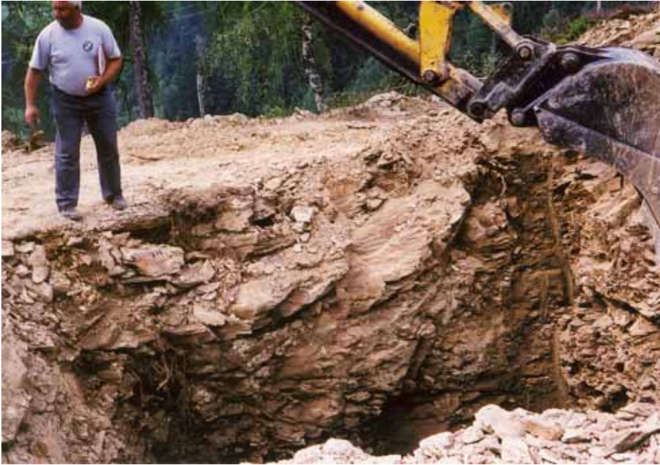
Slika 8. Primer izkopa na lokaciji Pernice. Opravljen je izkop v matično kamnino do globine cca 4,50 m.
