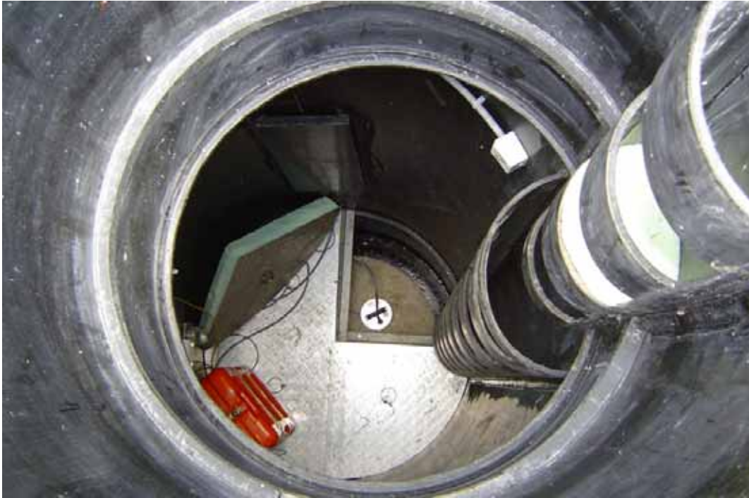
Slika 18. Pogled v jašek z merilnimi instrumenti. Senzor je postavljen na podlago in s toplotno izolacijsko steno ločen od ostalega prostora z zajemalno napravo.
