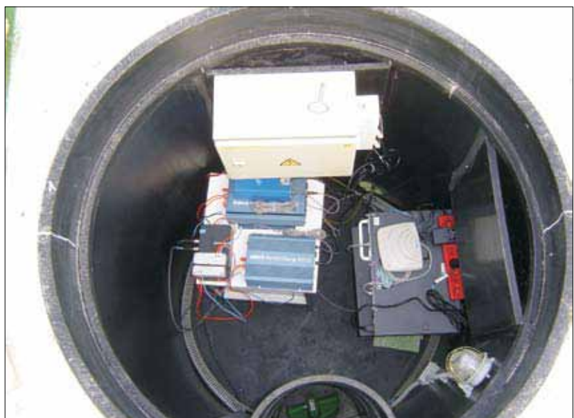
Slika 41. Pomožni jašek z brezprekinitvenim napajanjem in modemom ter usmerjevalnikom za prenos podatkov.
