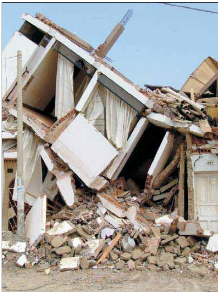
Sliki 8a,b. Porušitev 4-etažnega zidanega objekta. Etaže so se sesedle kot "palačinke".
