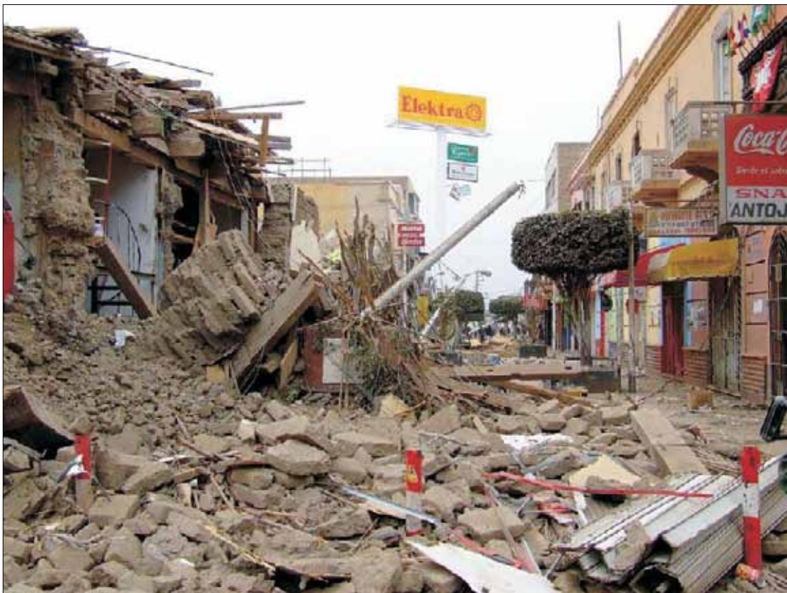
Sliki 4a,b. Značilna porušitev hiš zgrajenih iz na zraku sušene opeke. Tovrstne poškodbe so prevladovali v krajih Pisco, Ica in Chincha Alta (foto: A. Pedemonte).
