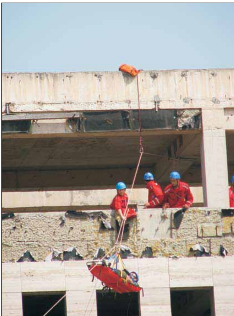
Slika 1. Iz višjih nadstropij poškodovanih objektov so po vrveh na nosilih spuščali ranjence.
