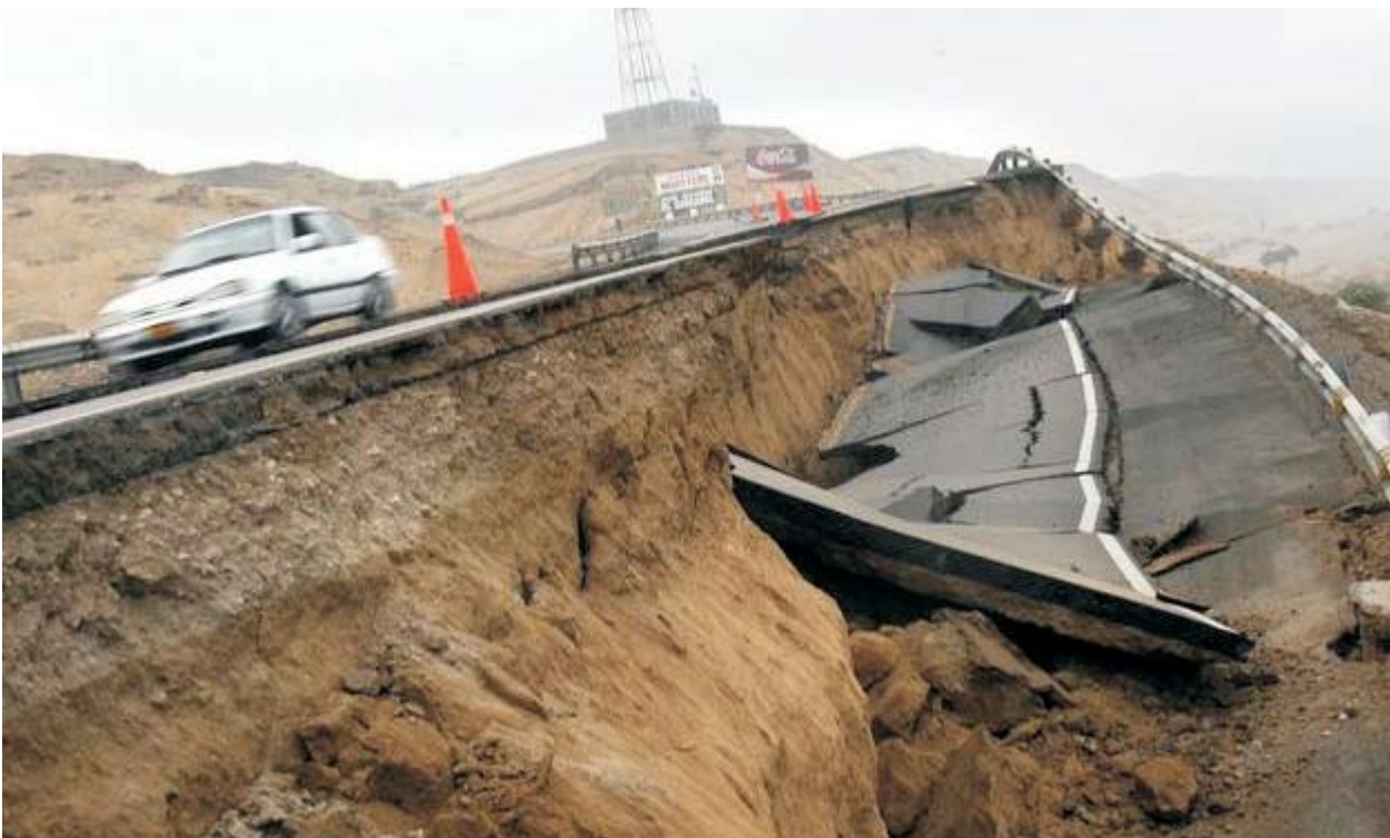
Slike 12a,b,c. Delna porušitev cestišča na obalni cesti Panamericana v okolici nadžarišča.
