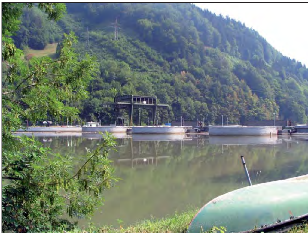
Slika 2. Pogled na pregrado HE Vuhred (foto: P. Zupančič).
