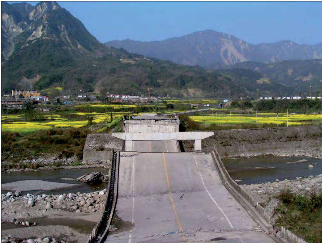
Slika 12. Poškodbe mostu v Xingyiu regiji so posledica velikih navpičnih premikov tal ob prelomu. Temeljna tla na bližnjem delu mostu so se namreč dvignila za 1,5 m glede na tla na drugi (oddaljeni) strani reke. Posledica tako velikih premikov je popolna porušitev posameznih razponov mosta.
