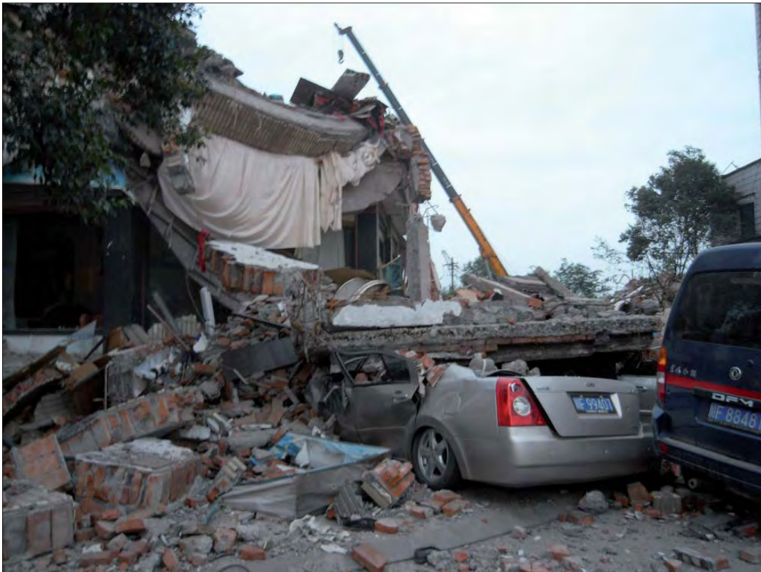
Slika 7. Potres je porušil večino zgradb v mestu Hanwang, Sichuan.
