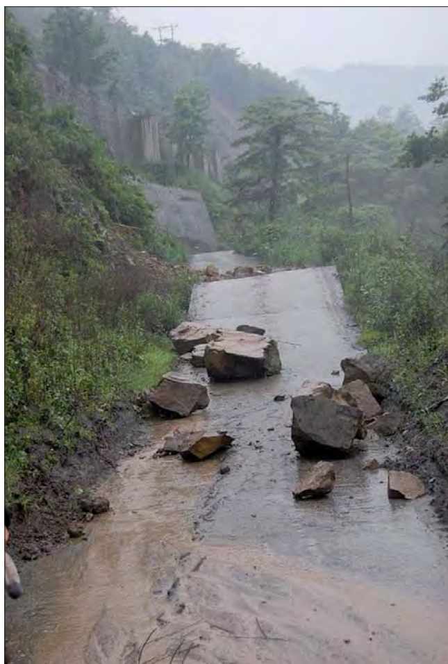
Slika 11. Plazovi niso le zasuli posameznih cest, temveč so le te splazele z ostalo zemeljsko maso (primer ceste pri Dujiangyan, Sichuan).
