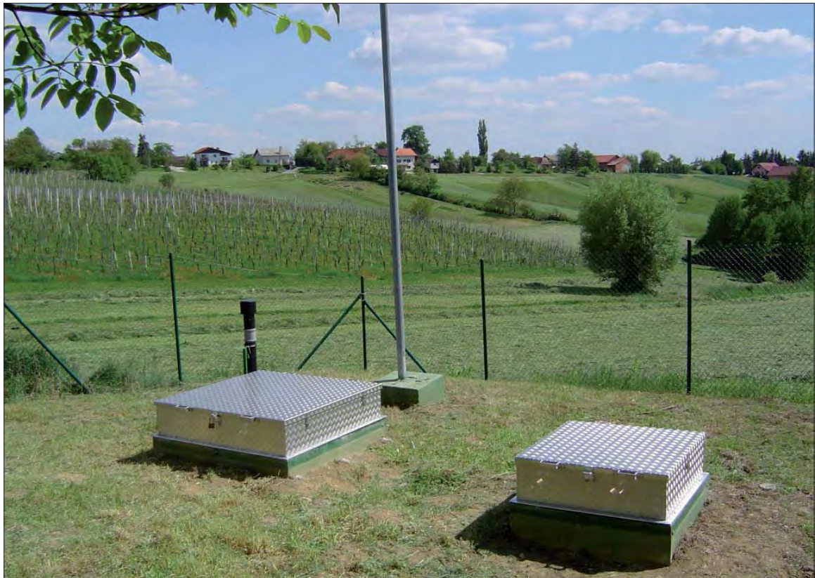
Slika 5. Novi pokrovi iz aluminija so lažji, boljše tesnenje pa preprečuje žuželkam, mravljam in drugim malim živalim naselitev v jaskih (foto: P. Sinčič).
