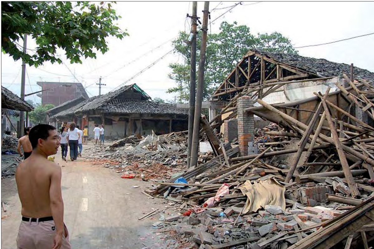
Slika 9. Močno so bili poškodovani tudi tradicionalni leseni stanovanjski objekti.
