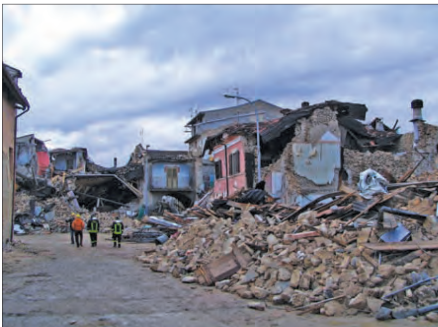
Slika 10. Onna: popolna porušitev večine objektov v vasi, v kateri je umrlo 40 prebivalcev od dvestotih. Vzrok zanjo je slaba gradnja na mehki geološki podlagi, ki je povzročila okrepitev potresnih valov. Porušene hiše so bile zidane iz neobdelanega in le delno obdelanega kamna v slabi malti. Nekaj novejših montažnih objektov v vasi je potres prestalo le z majhnimi poškodbami. (avtor posnetka: M. Godec)
