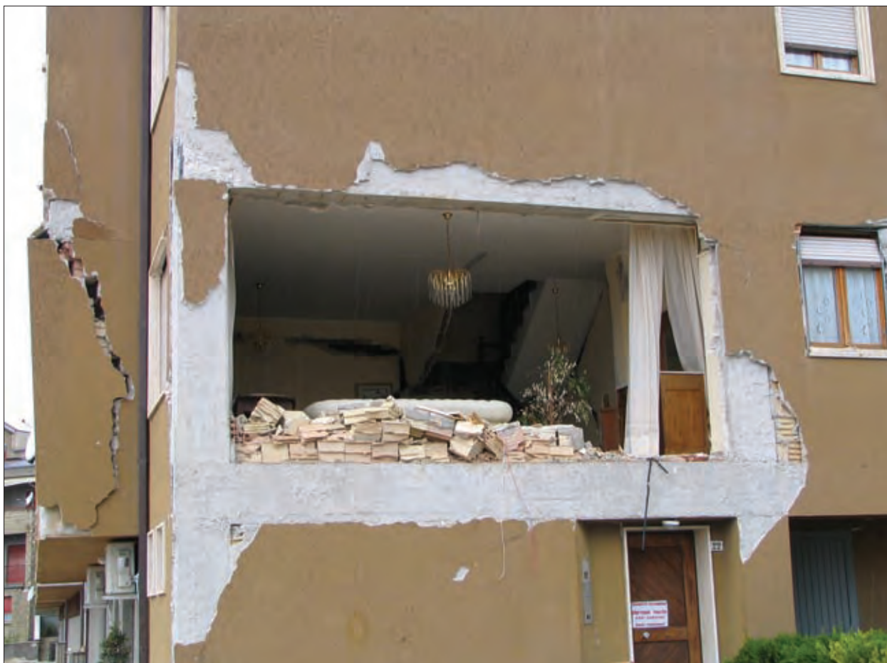
Slika 14. Pettino: porušitev polnil. (avtor posnetka: M. Godec)
