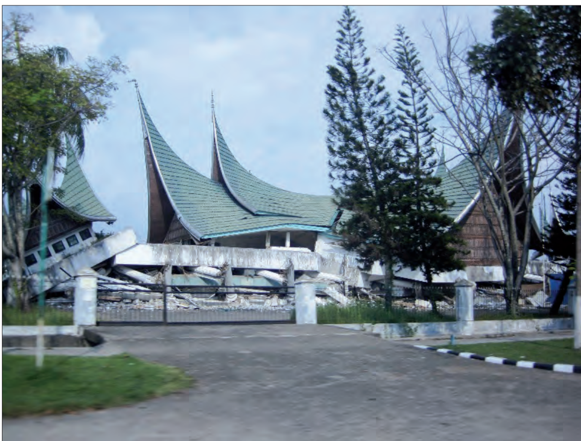
Slika 5. Poškodovana vladna palača v Padangu, Indonezija. (vir: http://en.wikipedia.org/wiki/File:Padang_earthquake.jpg )
