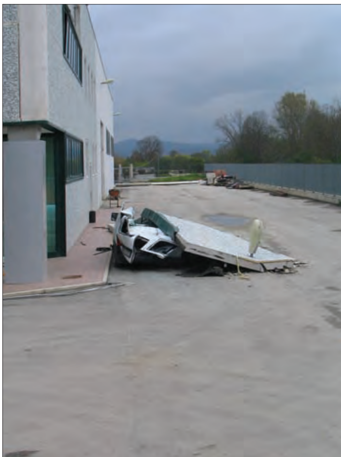
Slika 14. Pettino: porušitev polnil. (avtor posnetka: M. Godec)
