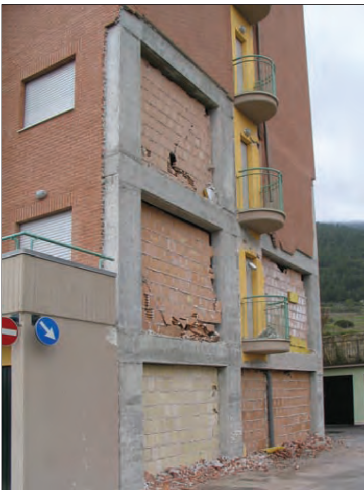
Slika 16. Pettino: pri novejših armiranobetonskih okvirjih je pogosto prišlo do porušitve polnil. Takšen tip gradnje stanovanjskih objektov je na prizadetem območju zelo pogost, mnogo je bilo še nevseljenih objektov z enakim tipom poškodb. (avtor posnetka M. Godec)
