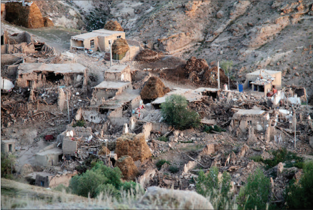
Slika 3: Veliko vasi je bilo v potresu 11. avgusta uničenih, vas Ishikhli blizu mesta Varzaqan, Iran. (Vir: http://www.boston.com/bigpicture/2012/08/iran_earthquakes.html )
