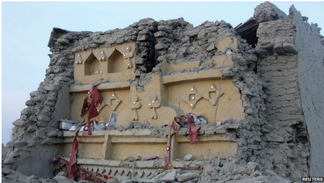
Slika 4: Porušena zgradba, narejena iz opeke iz blata (Vir: http://www.bbc.com/news/world-asia-2422276 )
