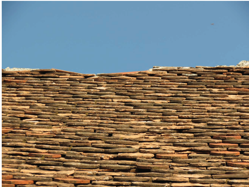
Slika 5: Odpadli slemenski strešniki v Tomšičevi ulici v Postojni (foto: M. Godec)
