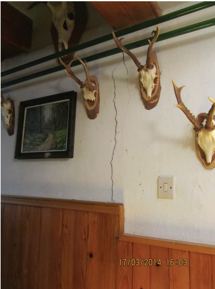
Slika 10: Globoka razpoka v steni (foto: P. Zupančič)
