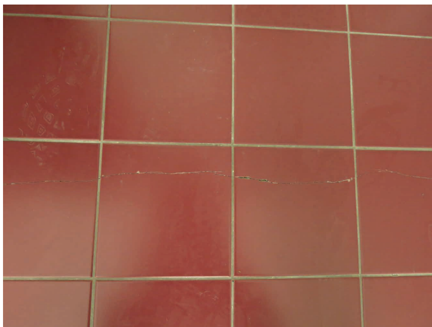
Slika 6: Počena stenska keramika v Parku vojaške zgodovine na Kolodvorski cesti v Pivki (foto: M. Godec)
