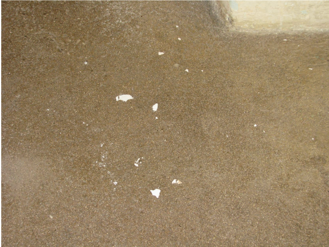
Slika 6: Odpadanje koščkov ometa (foto: M. Godec)
