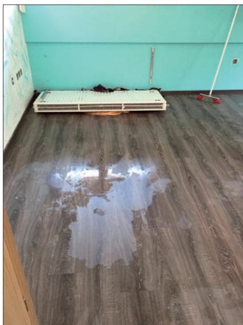
Slika 3: V novejši hiši na Vinjem Vrhu je z nosilcev odtrgalo radiator (foto J. Kodrič).
