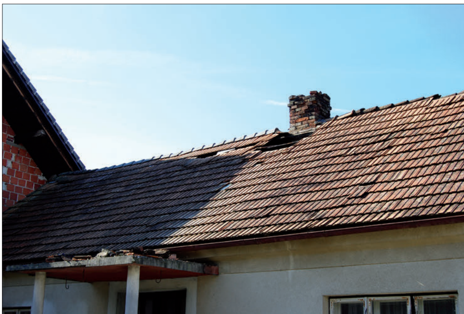
Slika 15: Odlom dimnika na Hrastjah pri Cerkljah (foto I. Cecić)
