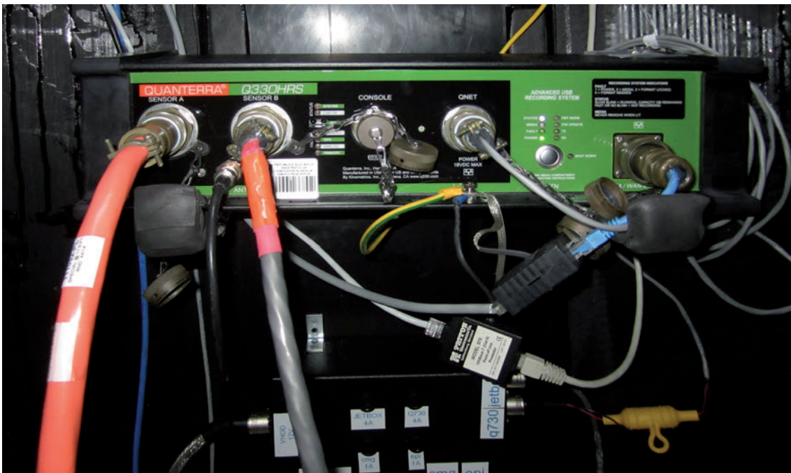
Slika 2: Namestitev nove zajemalne enote Quanterra Q330HRS v seizmičnem jašku. (foto: I. Tasič). Figure 2: Installation of new acquisition unit Quanterra Q330 in seismic shaft. (Photo: I. Tasič).
