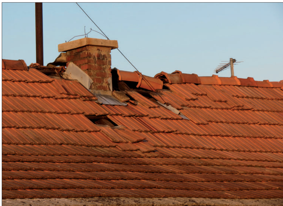
Slika 8: Premaknjeni strešniki na Stojanskem Vrhu (foto M. Godec)
