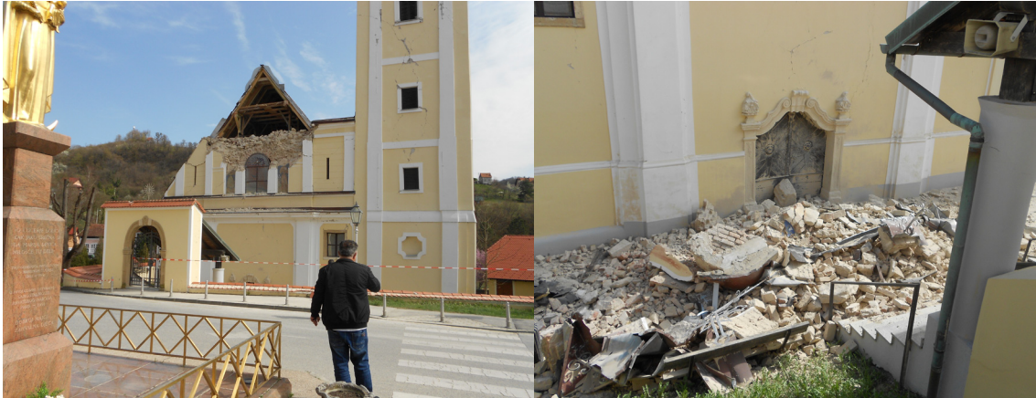
Slika 2. Delna porušitev fasade cerkve v kraju Čučerje, 11 km SV od centra Zagreba. (foto I. Sović, Hrvatska seizmološka služba).
